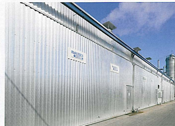
Der Einschnitt aus dem hauseigenen Sägewerk und zugekauft Material werden in modernen Trockenkammern getrocknet
