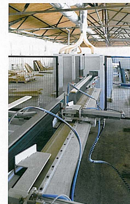
In der Übergabestation werden die Lamellen an den Puffer vor der Beleimung übergeben
